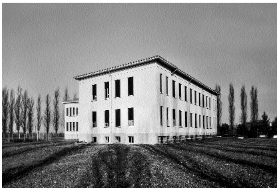
L'ala est del fabbricato.
