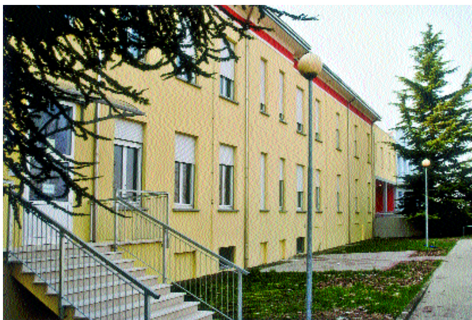
Corpo centrale con scalinata che porta alla cappella interna.
